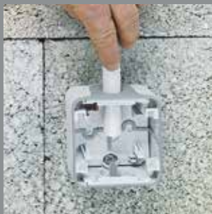
2/ Vložte trubku cez vytvorený otvor
